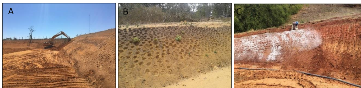
Figura 49. Exemplos de preparação do solo para aplicação de hidrossemeadura: A= Nivelamento, B= Picoteamento e C= Correção do Solo.
