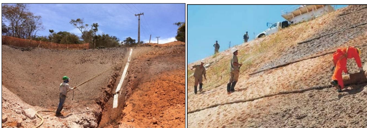
Figura 50. Demonstração da aplicação de hidrossemeadura em taludes de corte. Fonte: CBCN, 2010.
